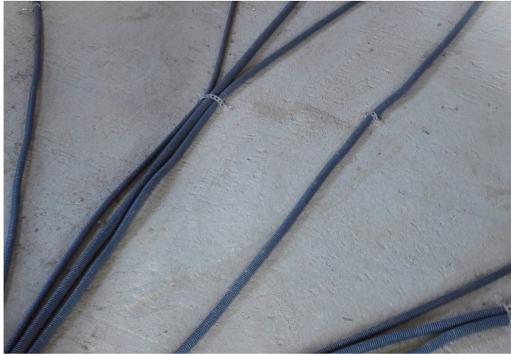
FIGURE 20 – Gainses préfilées posées au sol
